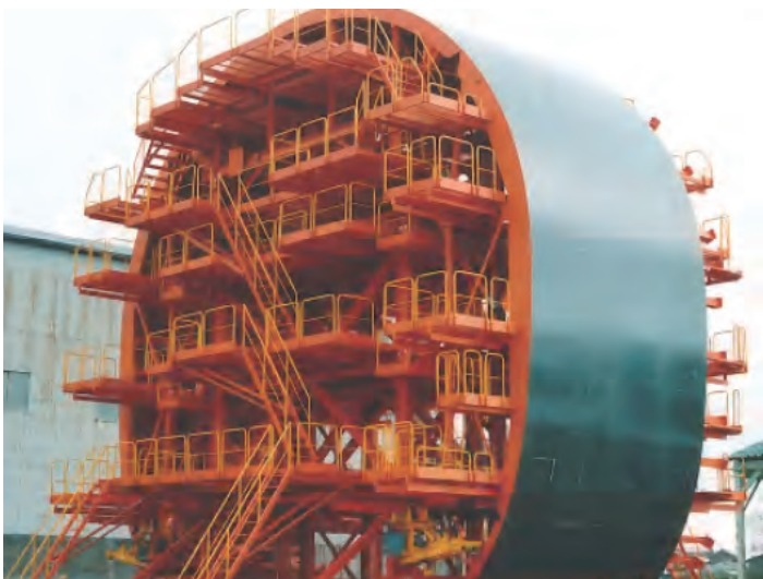
地下調整池用スチールフォーム
